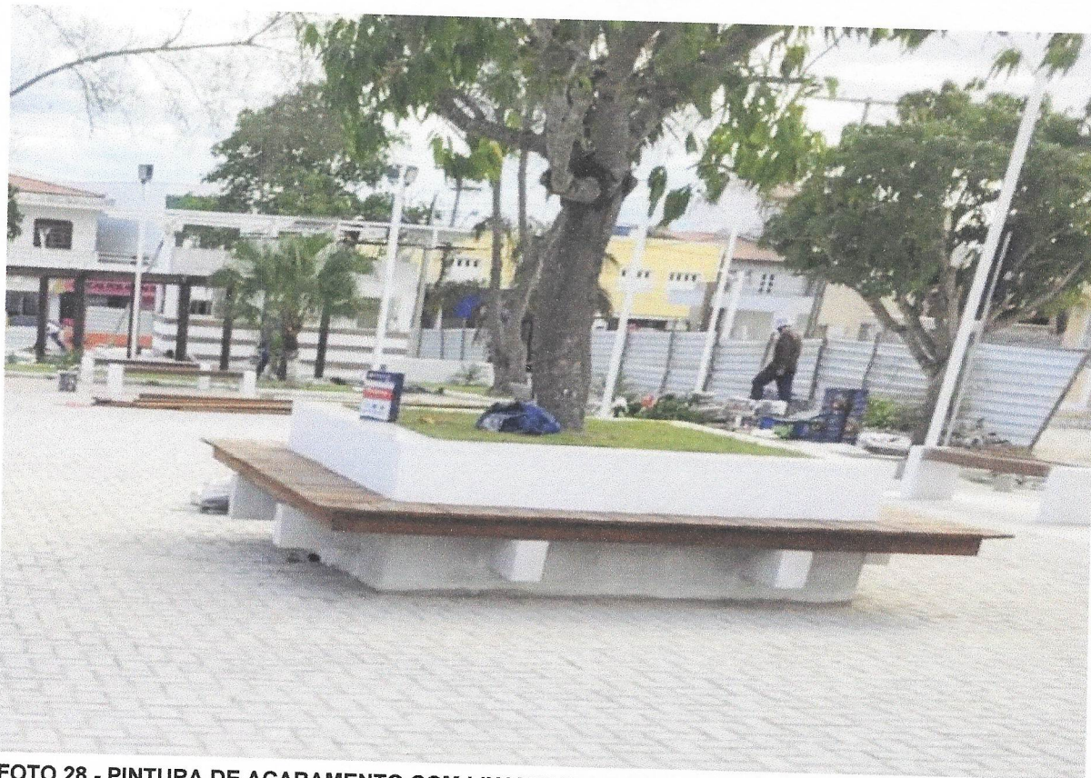
FOTO 27 - PINTURA DE ACABAMENTO COM LIXAMENTO E APLICAÇÃO DE 02 DEMÃOS DE ESMALTE SINTÉTICO BRILHANTE SOBRE MADEIRA (SUVINIL OU SIMILAR)
