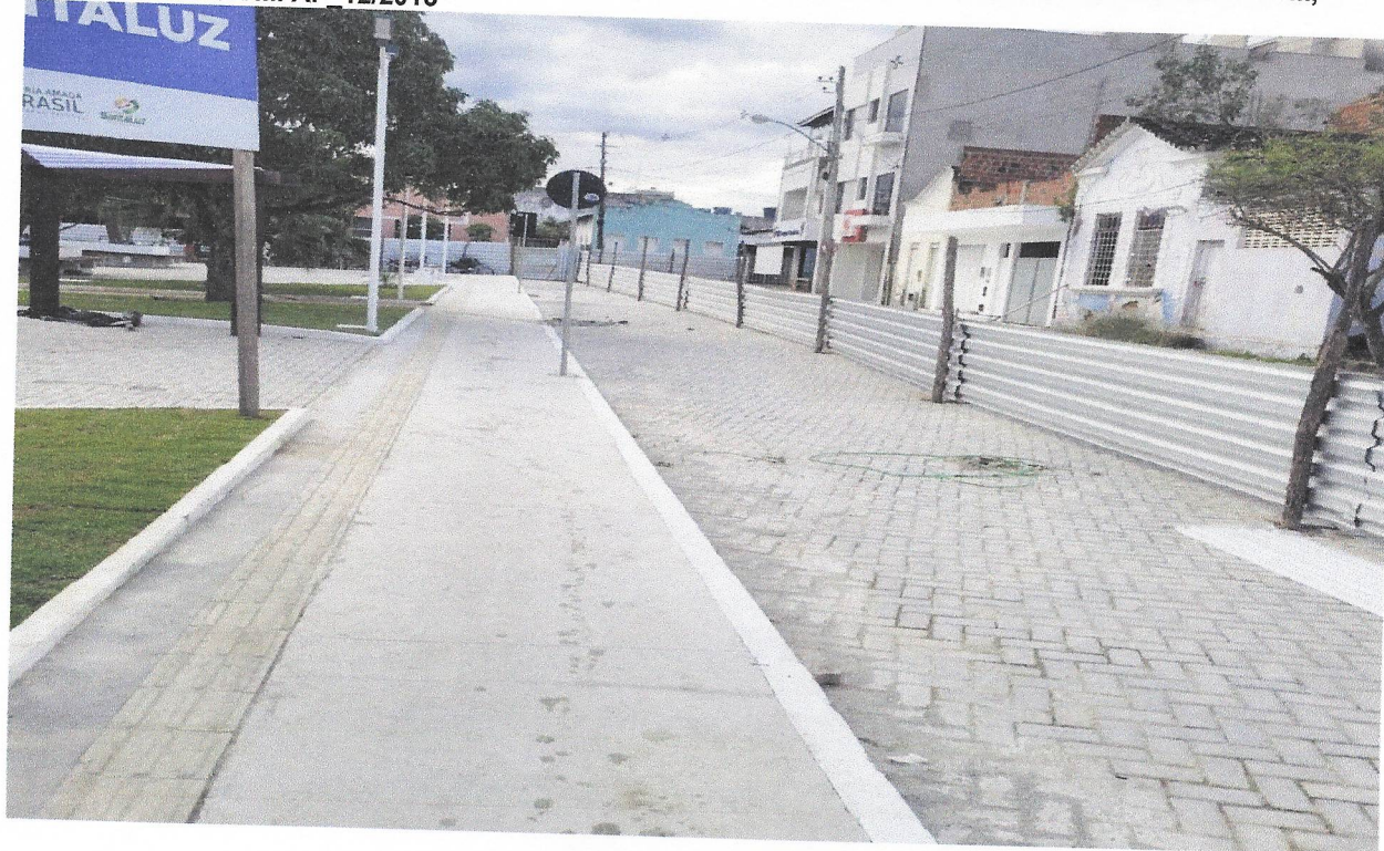
FOTO 49 - EXECUÇÃO DE VIA EM PISO INTERTRAVADO, COM BLOCO RETANGULAR DE 20 X 10 CM, ESPESSURA 10 CM. AF_12/2015
