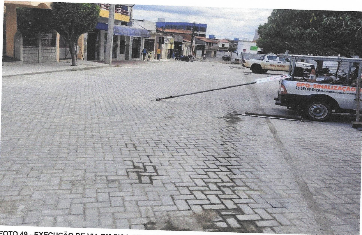
FOTO 48 - EXECUÇÃO DE VIA EM PISO INTERTRAVADO, COM BLOCO RETANGULAR DE 20 X 10 CM, ESPESSURA 10 CM. AF_12/2015
