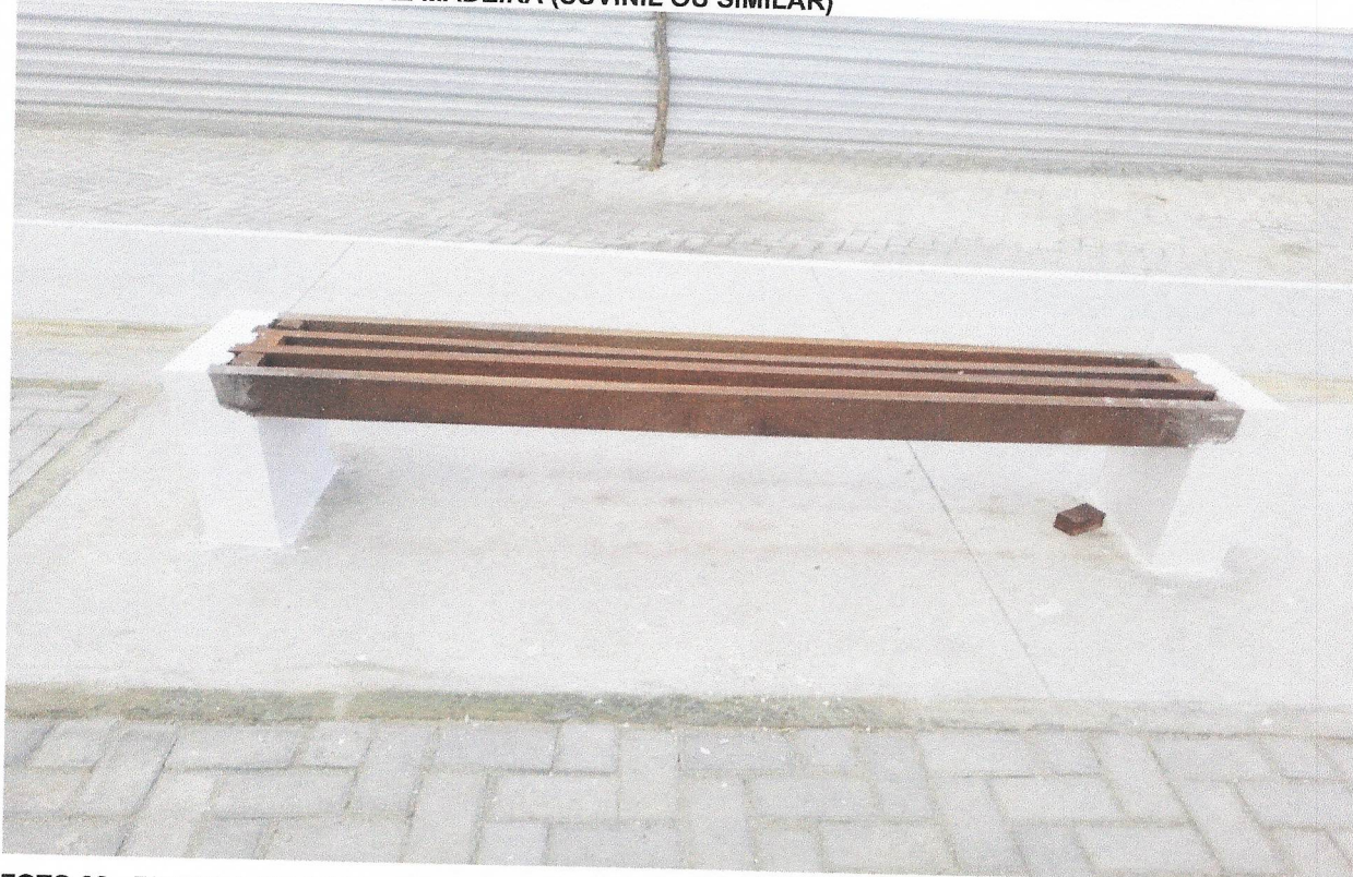
FOTO 38 - PINTURA DE ACABAMENTO COM LIXAMENTO E APLICAÇÃO DE 02 DEMÃOS DE ESMALTE SINTÉTICO BRILHANTE SOBRE MADEIRA (SUVINIL OU SIMILAR)
