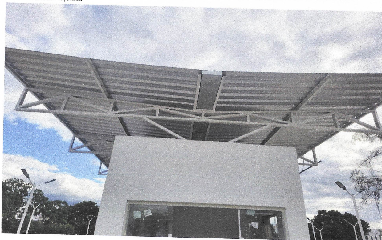
FOTO 14 - TELHAMENTO COM TELHA METÁLICA EM CHAPA DE AÇO GALVANIZADO NATURAL ONDULADA E=0,5MM
