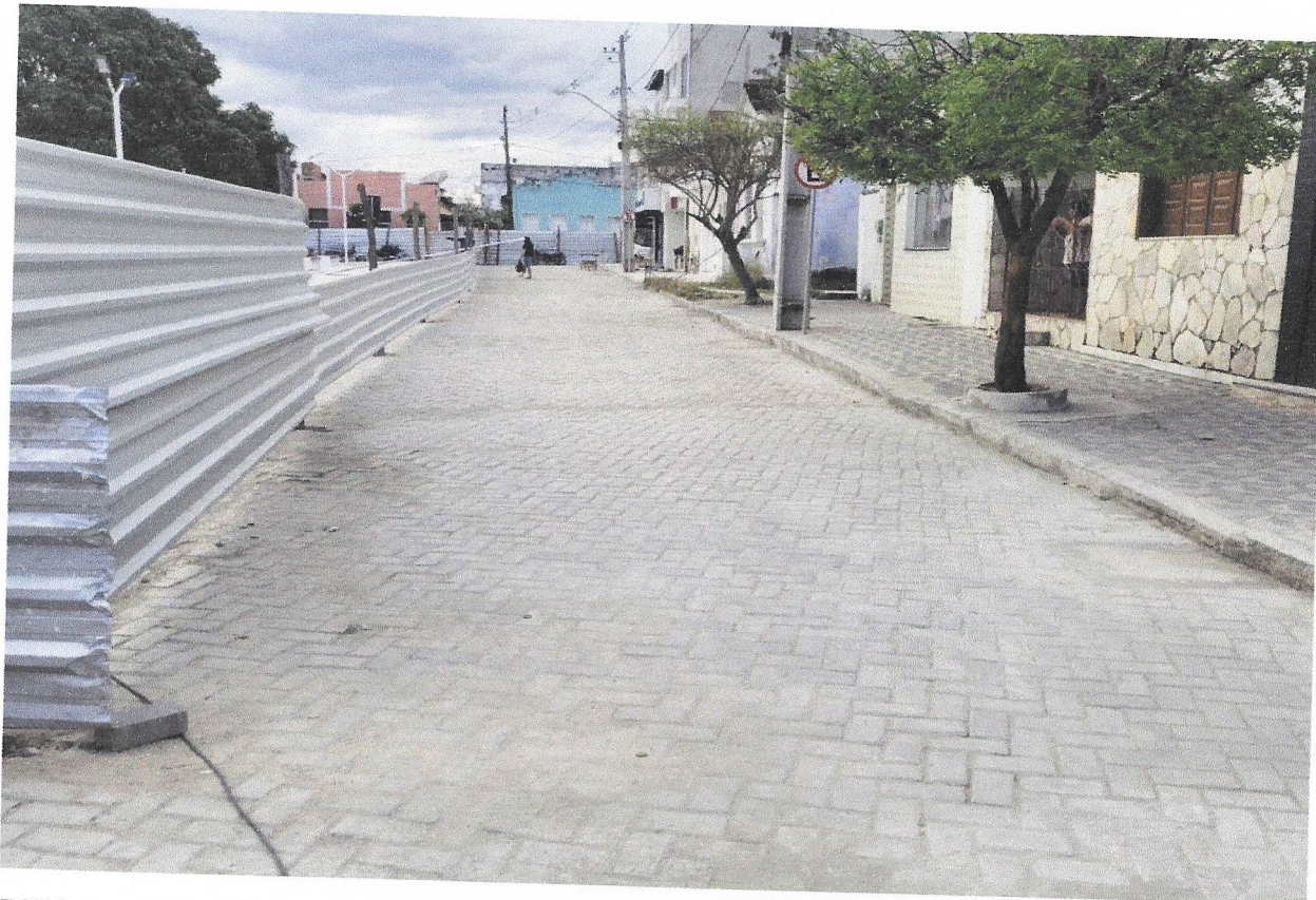
FOTO 51 - EXECUÇÃO DE VIA EM PISO INTERTRAVADO, COM BLOCO RETANGULAR DE 20 X 10 CM, ESPESSURA 10 CM. AF_12/2015
