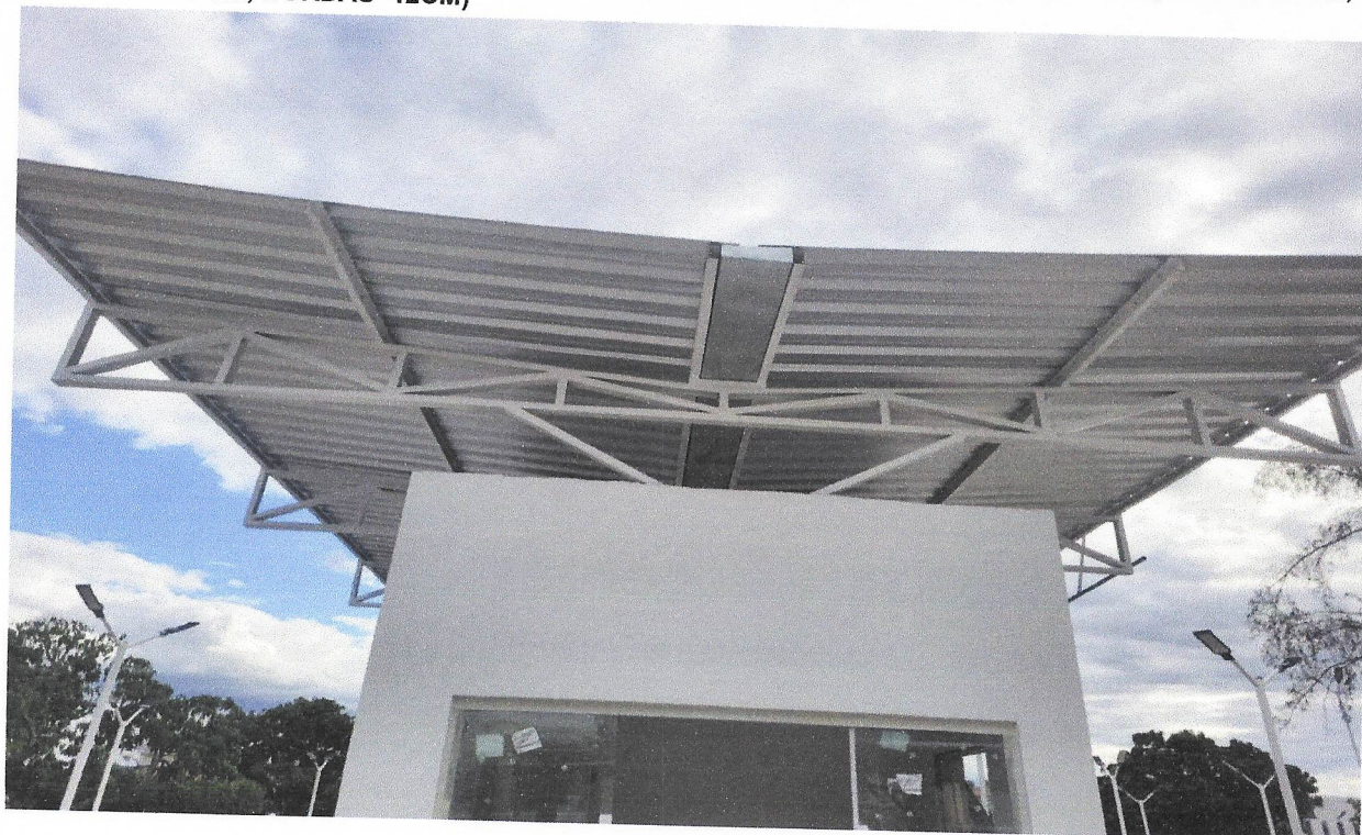
FOTO 16 - CALHA EM CHAPA DE AÇO GALVANIZADO Nº 26, DESENVOLVIMENTO 86 CM (FUNDO=32 CM, LATERAIS=15 CM, BORDAS=12CM)
