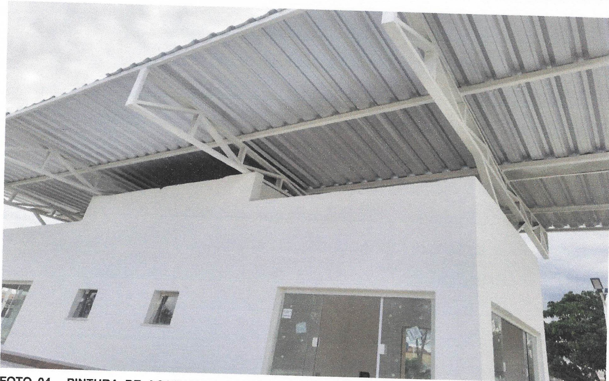
FOTO 04 - PINTURA DE ACABAMENTO COM APLICAÇÃO DE 01 DEMÃO DE VERNIZ ACRÍLICO PARA PROTEÇÃO DE SUPERFÍCIES EM CONCRETO APARENTE, MARCA FOSROC, REF DEKGUARD FS OU SIMILAR- R1
