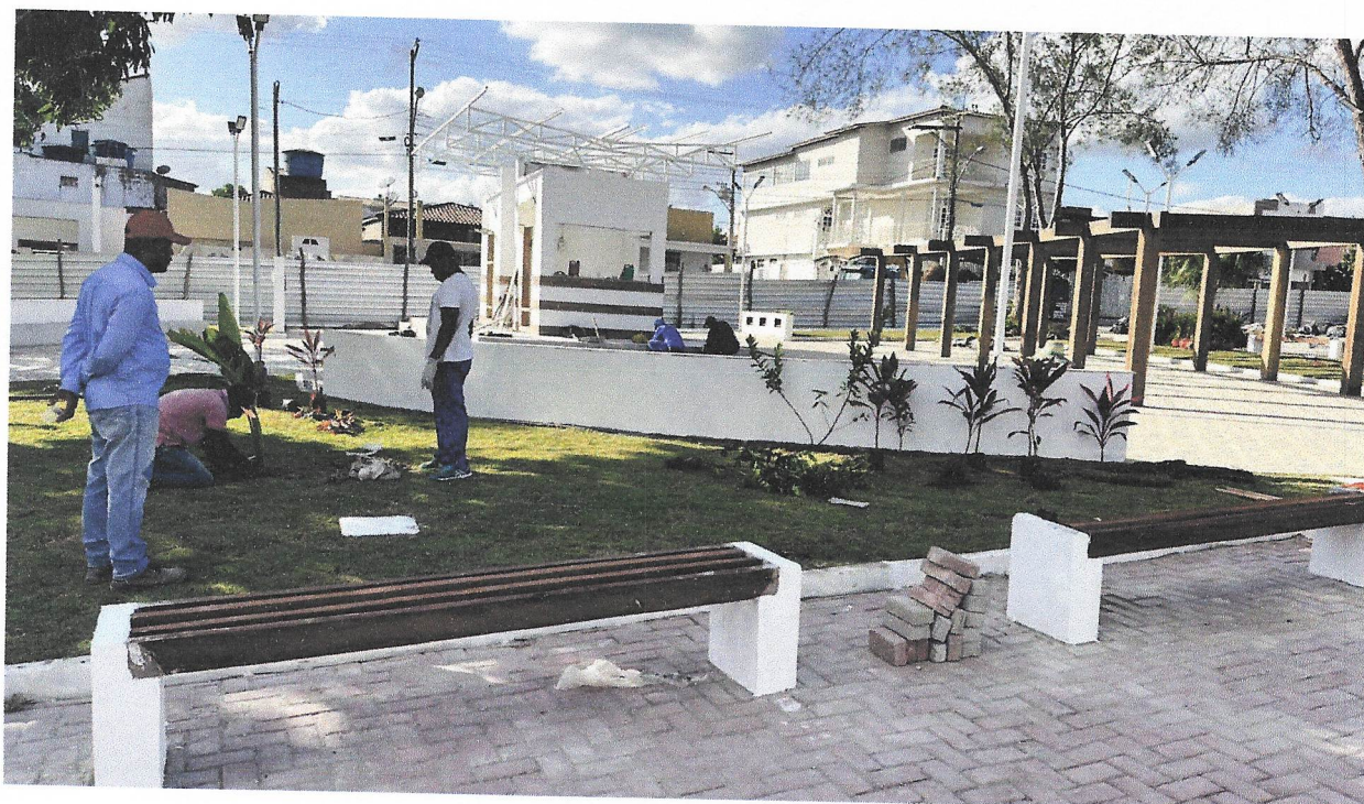
FOTO 38 - PINTURA DE ACABAMENTO COM LIXAMENTO E APLICAÇÃO DE 02 DEMÃOS DE ESMALTE SINTÉTICO BRILHANTE SOBRE MADEIRA (SUVINIL OU SIMILAR)
