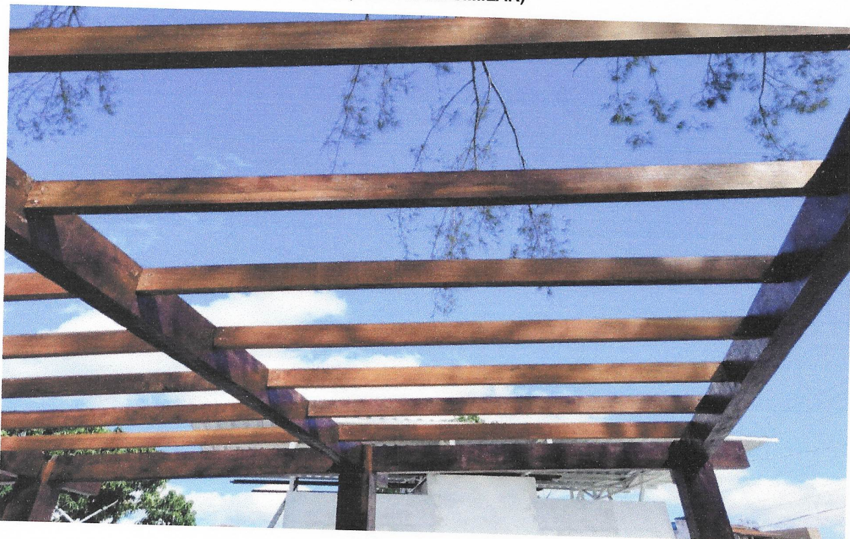
FOTO 22 - PINTURA DE ACABAMENTO COM LIXAMENTO E APLICAÇÃO DE 02 DEMÃOS DE ESMALTE SINTÉTICO BRILHANTE SOBRE MADEIRA (SUVINIL OU SIMILAR)
