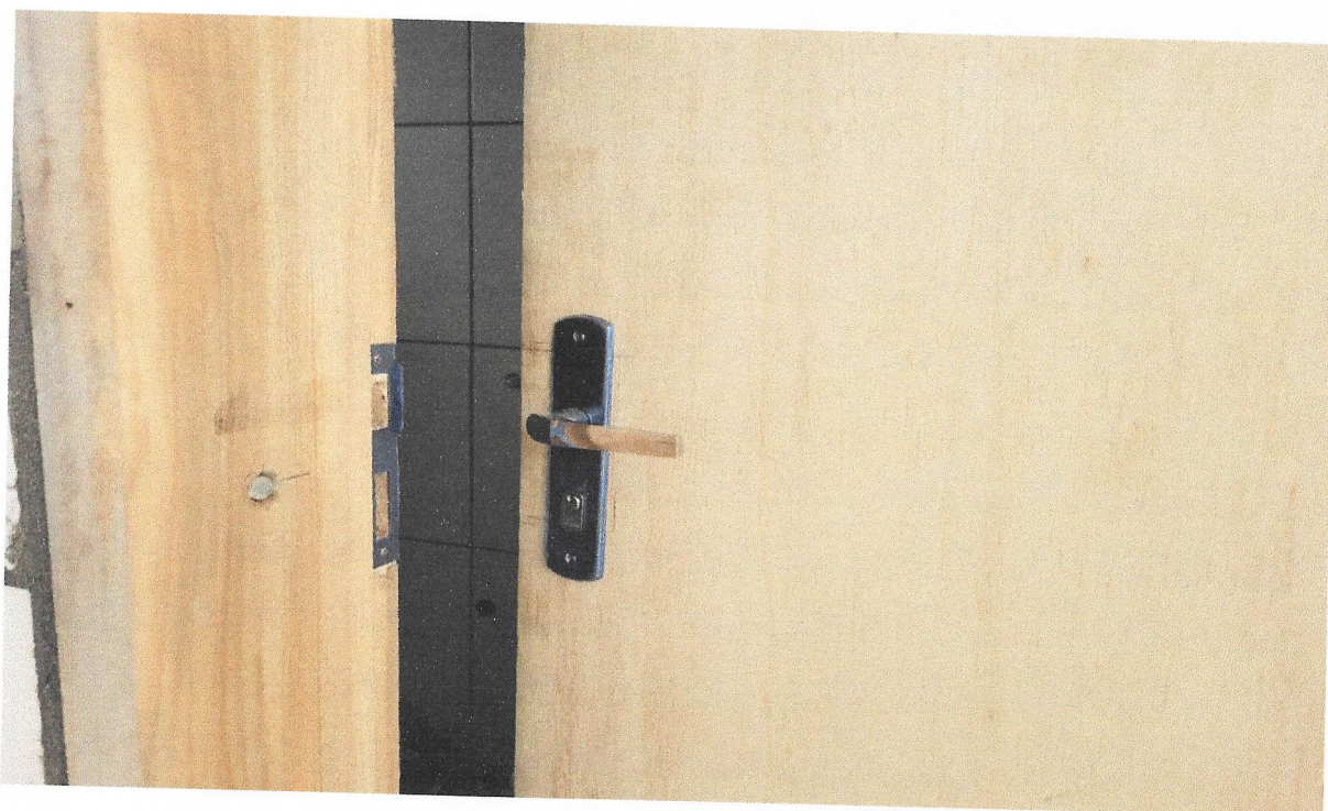
FOTO 12 - FECHADURA DE EMBUTIR PARA PORTAS INTERNAS, COMPLETA, ACABAMENTO PADRÃO MÉDIO, COM EXECUÇÃO DE FURO - FORNECIMENTO E INSTALAÇÃO. AF_12/2019
