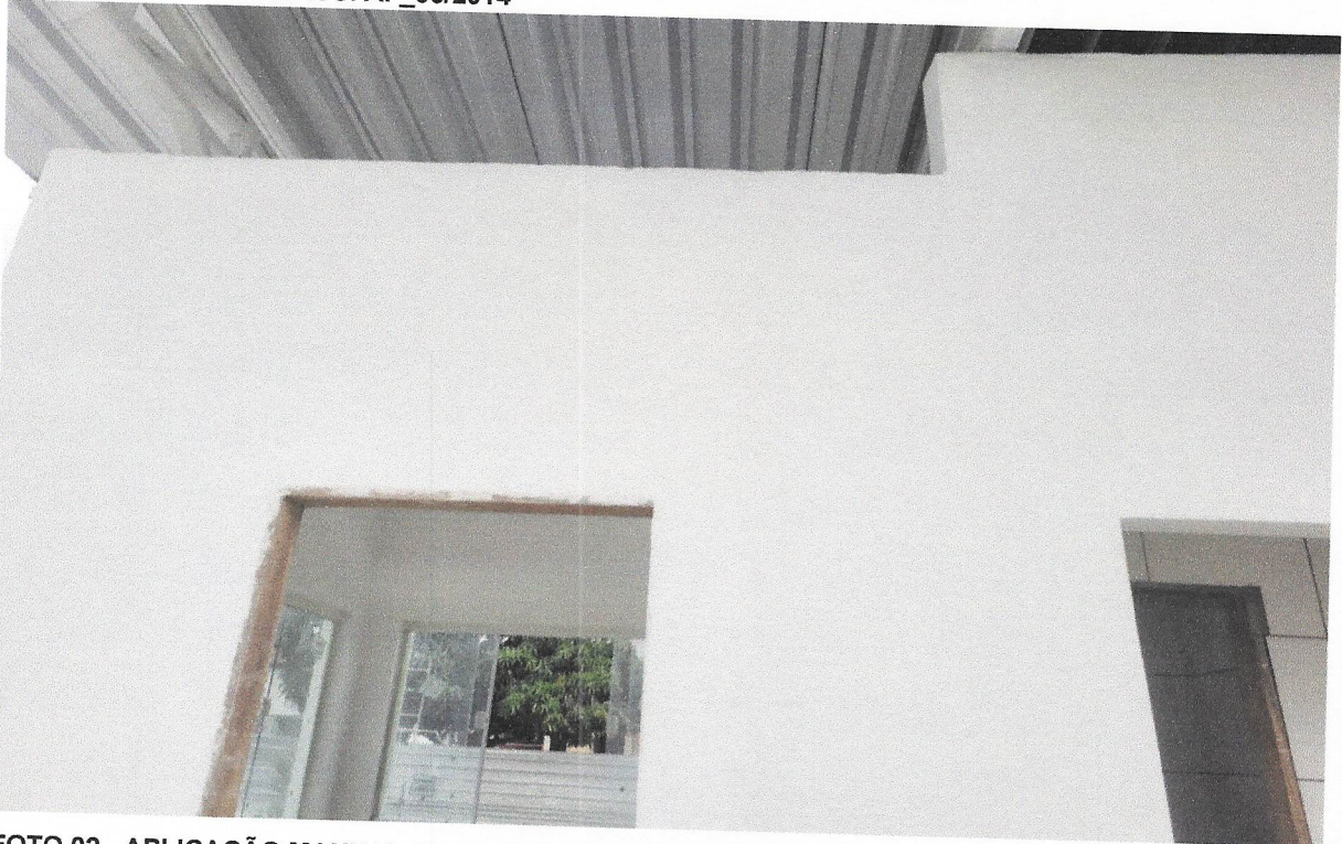
FOTO 02 - APLICAÇÃO MANUAL DE PINTURA COM TINTA LÁTEX ACRÍLICA EM PAREDES, DUAS DEMÃOS. AF_06/2014
