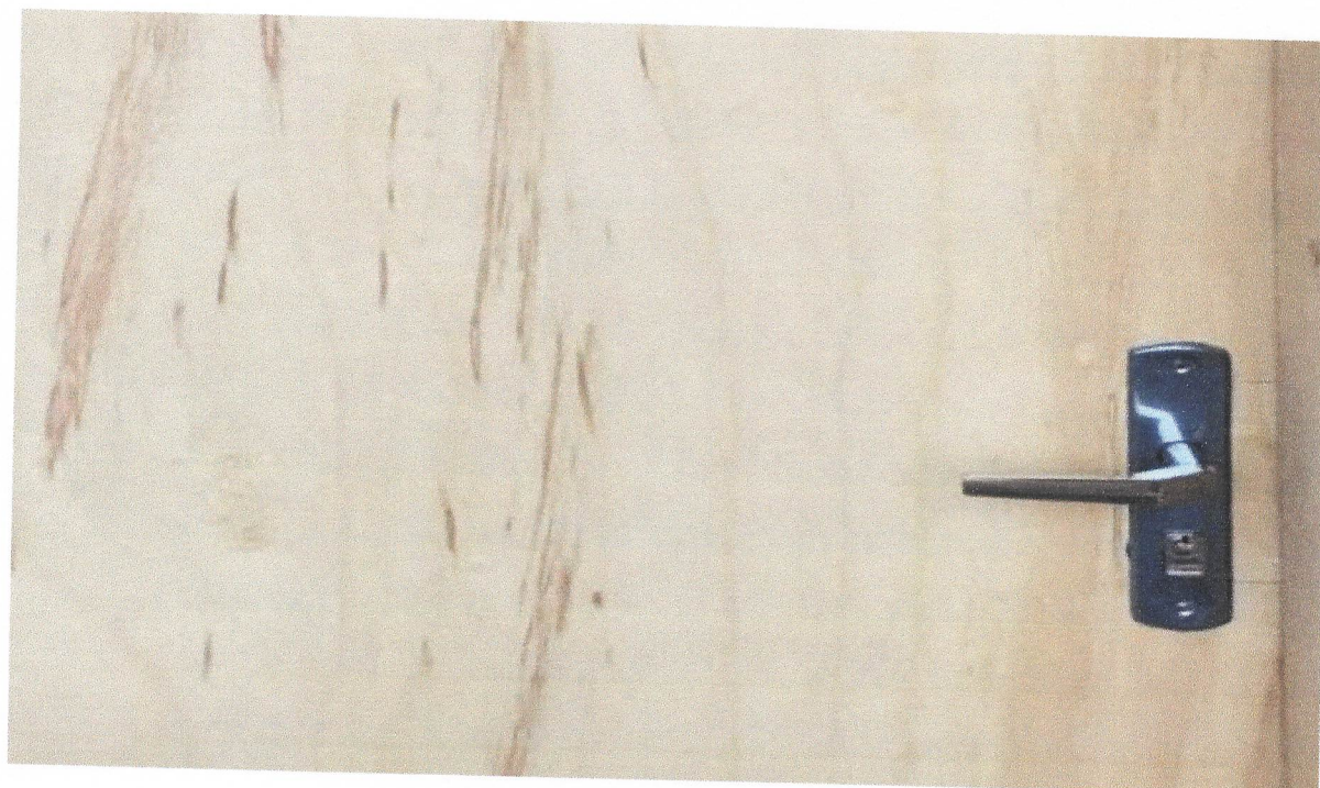
FOTO 12 - FECHADURA DE EMBUTIR PARA PORTAS INTERNAS, COMPLETA, ACABAMENTO PADRÃO MÉDIO, COM EXECUÇÃO DE FURO - FORNECIMENTO E INSTALAÇÃO. AF_12/2019
