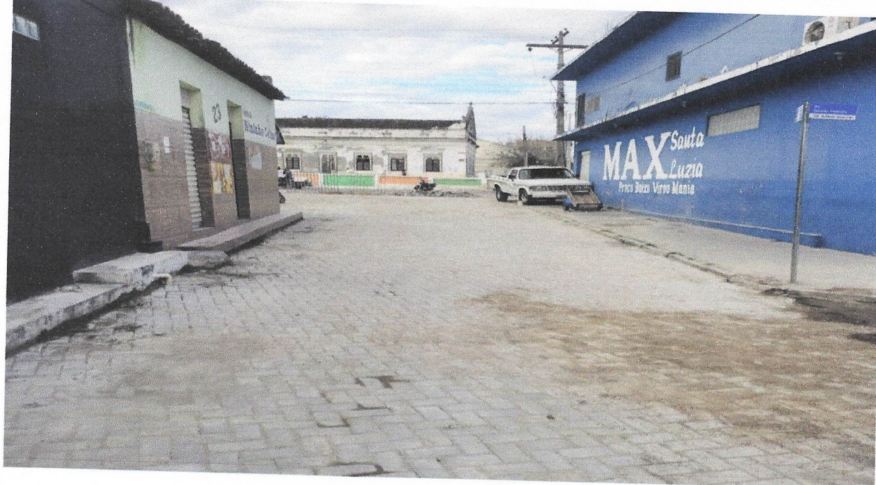
FOTO 51 - EXECUÇÃO DE VIA EM PISO INTERTRAVADO, COM BLOCO RETANGULAR DE 20 X 10 CM, ESPESSURA 10 CM. AF_12/2015
