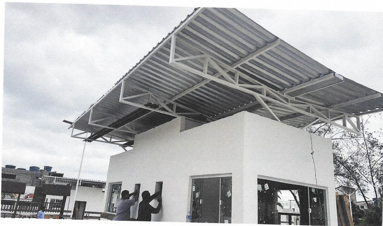
FOTO 14 - TELHAMENTO COM TELHA METÁLICA EM CHAPA DE AÇO GALVANIZADO NATURAL ONDULADA E=0,5MM
