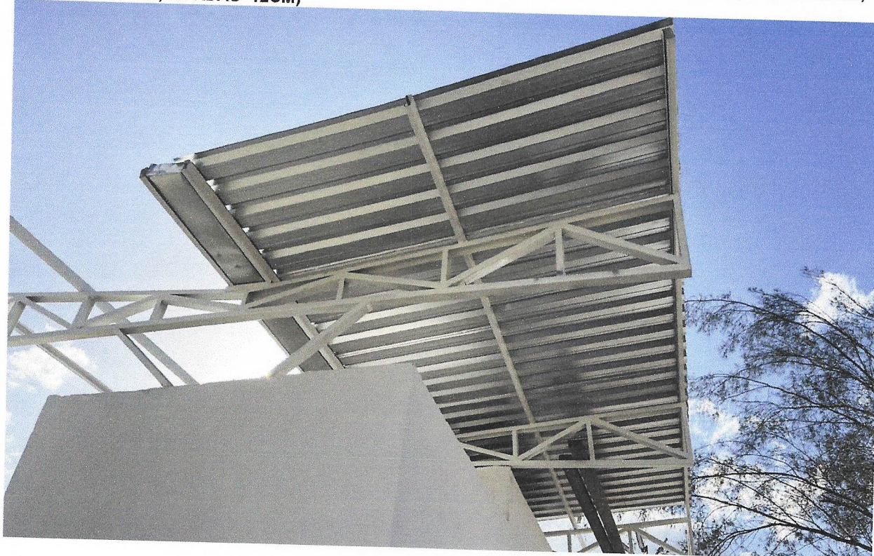
FOTO 16 - CALHA EM CHAPA DE AÇO GALVANIZADO Nº 26, DESENVOLVIMENTO 86 CM (FUNDO=32 CM, LATERAIS=15 CM, BORDAS=12CM)
