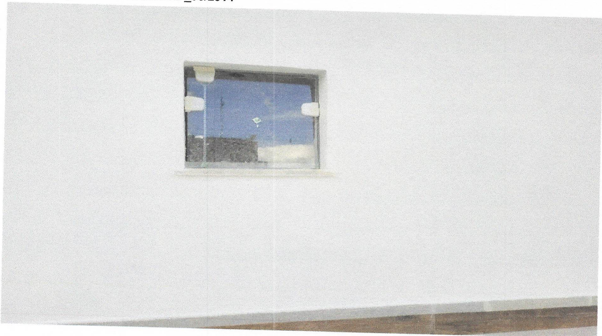
FOTO 02 - APLICAÇÃO MANUAL DE PINTURA COM TINTA LÁTEX ACRÍLICA EM PAREDES, DUAS DEMÃOS. AF_06/2014
